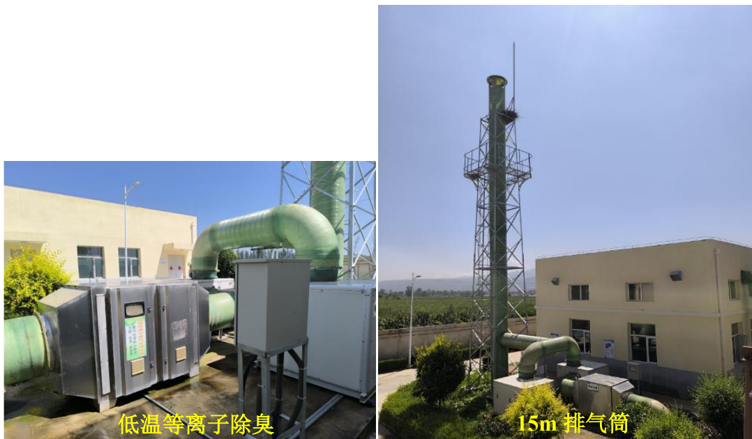
图 3-2 项目有组织恶臭气体治理设施控制措施照片
